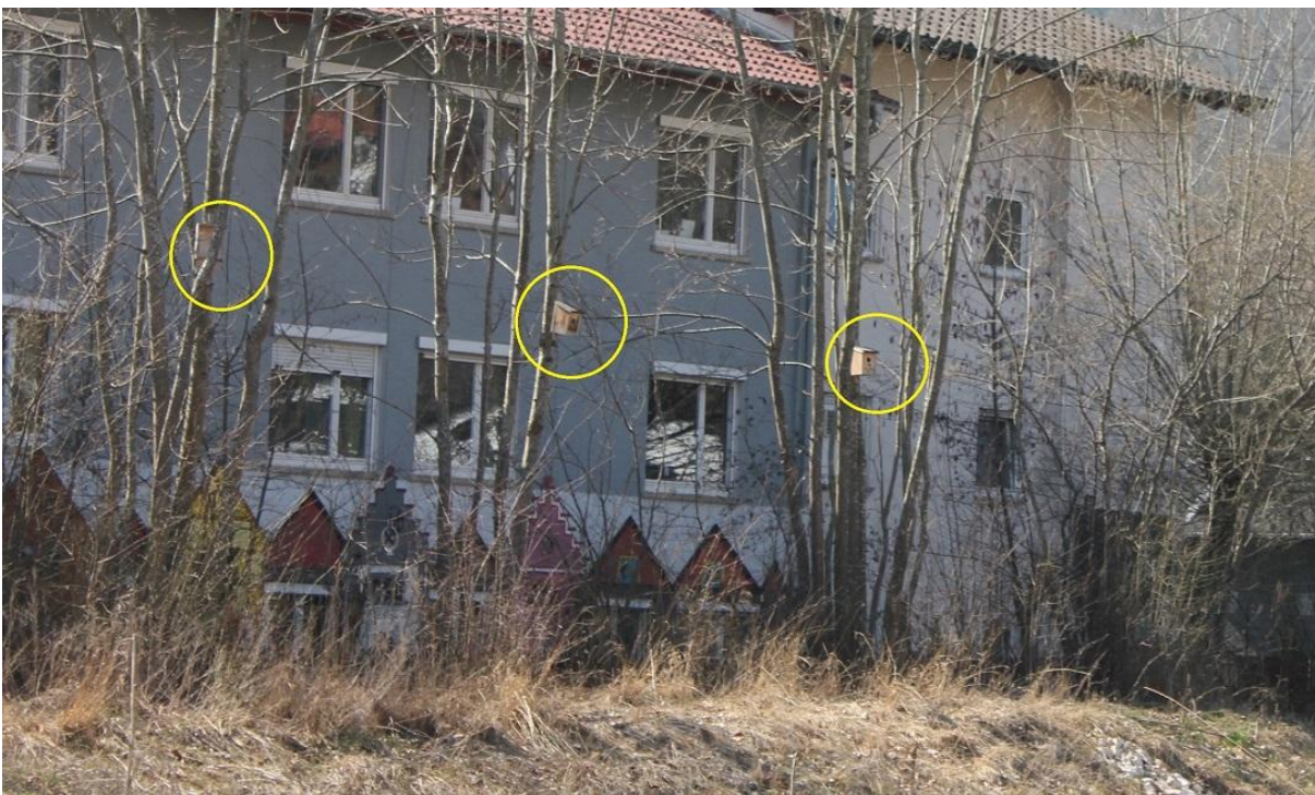
Abbildung 13: Dort befinden sich auch die Vogelnistkästen und Fledermauskästen als Ausgleichsmaßnahmen zu den Baumverlusten im Zusammenhang mit dem benachbarten Kinderhaus
