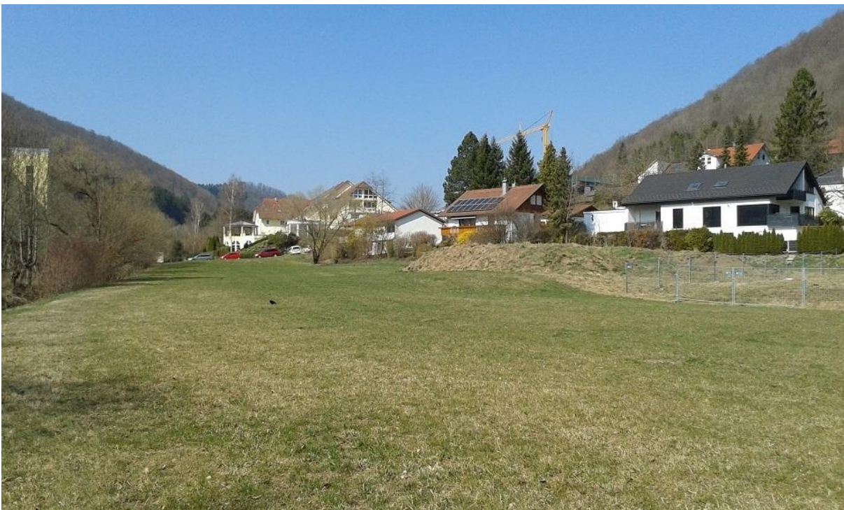
Abbildung 5: Blick auf die Fläche für das Erweiterungsgebiet (Bildmitte, Hintergrund)
