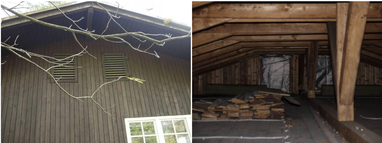
Abb. 11: Die potenzielle Einflugmöglichkeit ist mit einem Insektengitter versehen.
