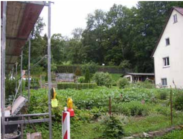
Abbildung 6 Das Gebiet ist durch Baustellen, Baulücken und Gärten gekennzeichnet
